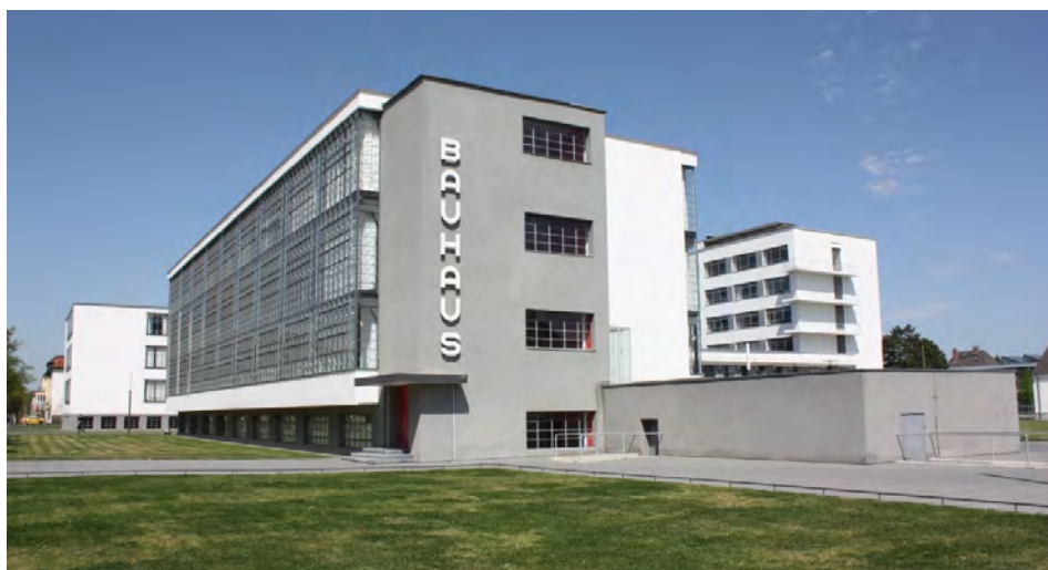
Rys. 1. Budynek Bauhausu. Widoczne skrzydło z głównym warsztatem. Szklana ściana pokrywa trzy kondygnacje budynku o żelbetowej konstrukcji
