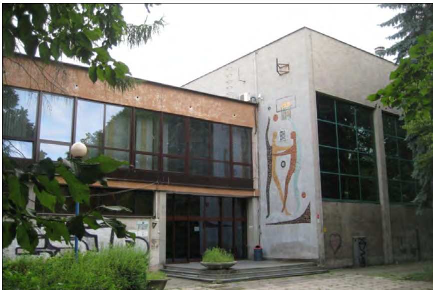
Rys. 2. Budynek Klubu „Politechnik”. Główna strefa wejściowa. Po prawej stronie skrzydło hali sportowej
