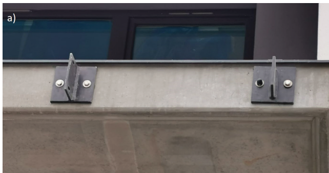
Rys. 7. Zalecane propozycje rozwiązań: a) doczołowe połączenia balustrad z płytą balkonową; b) wykończenie płyt balkonowych w postaci płyt ceramicznych na podkładkach dystansowych
