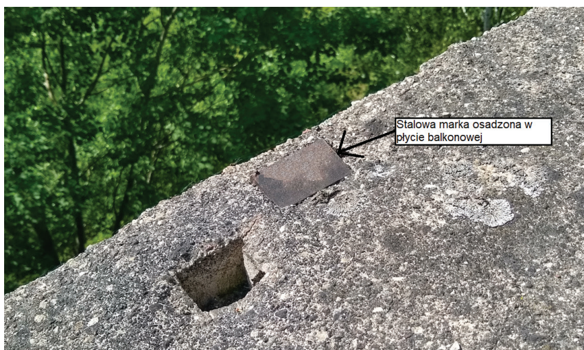
Rys. 1. Marka stalowa osadzona w płycie balkonowej systemu OWT
