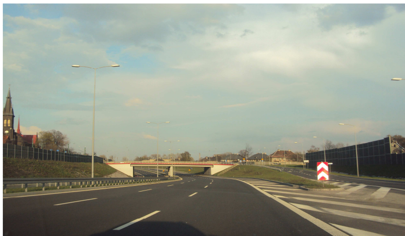
Rys. 4. Węzeł DTŚ usytuowany w Zabrzu dzielnicy Zaborze [4]
