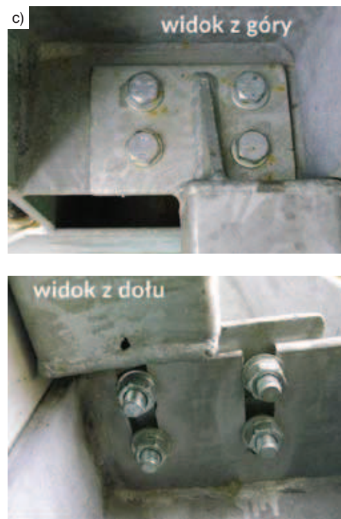
Rys. 14. Połączenie rygiel ścienny – słup w analizowanej hali: a) rozwiązanie pierwotne, b) rozwiązanie zamiennie wprowadzone przez wykonawcę, c) realizacja rozwiązania zamiennego stwarzająca zagrożenie katastrofą budowlaną
