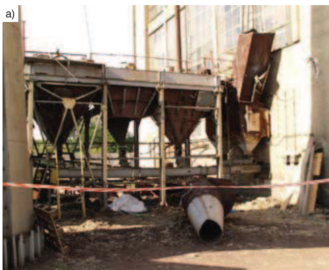
Rys. 4. Tragiczna w skutkach rozbiórka stalowych instalacji odpylania kotła, a) widok cyklonu, który śmiertelnie przygnoił robotnika; fot. z archiwum PIP [30], b) sekwencja zdarzeń (opis w tekście)
