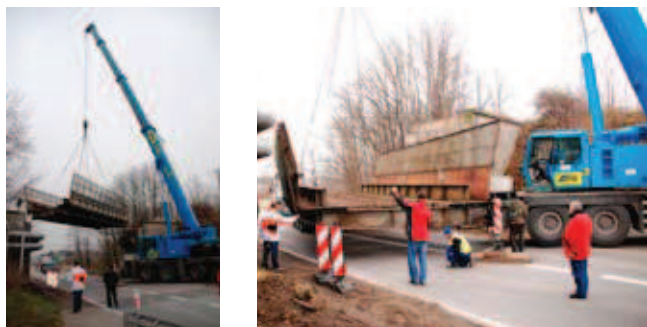
Rys. 7. Niezgodna z projektem rozbiórka stalowego wiaduktu; fot. z archiwum GDDKiA [29]
