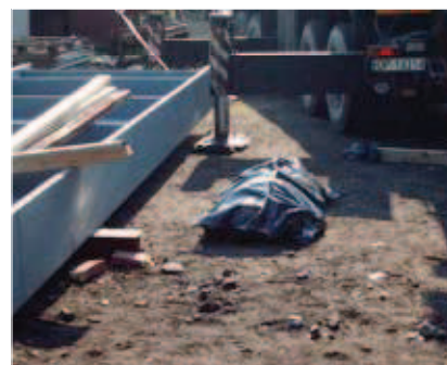
Rys. 8. Sekwencja wypadku i jego skutek – śmiertelne przygniecenie pracownika, wynikające z braku podparcia bocznego składowanych blachownic; fot. z archiwum PIP [30]
