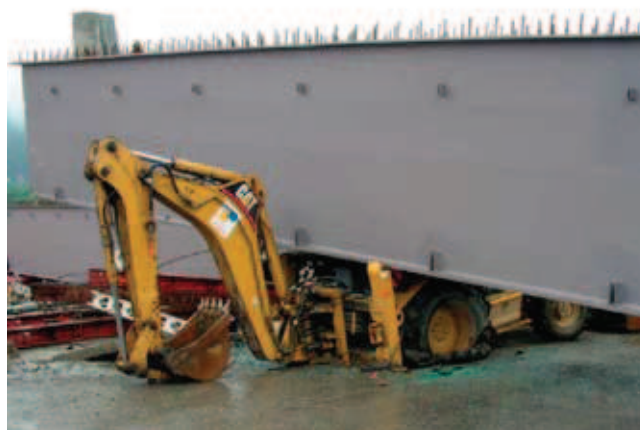
Rys. 9. Katastrofa w trakcie montażu stalowego wiaduktu drogowego spowodowana niewłaściwym przygotowaniem podłoża; fot. z archiwum PIP [30]
