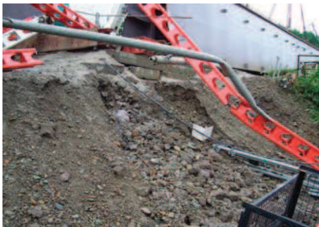
Rys. 9. Katastrofa w trakcie montażu stalowego wiaduktu drogowego spowodowana niewłaściwym przygotowaniem podłoża; fot. z archiwum PIP [30]
