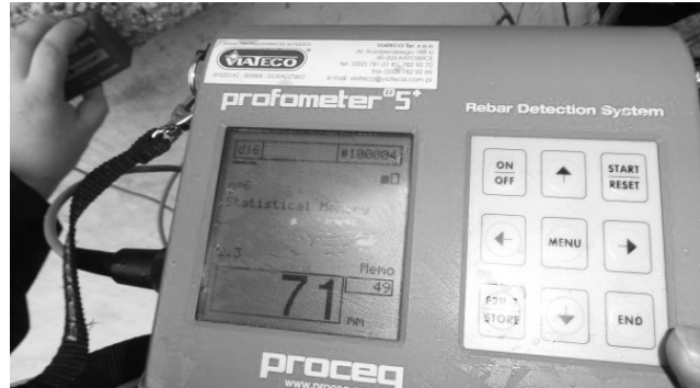
Rys. 10. Prace podczas sprawdzania detektorem zbrojenia ściany trójwarstwowej
