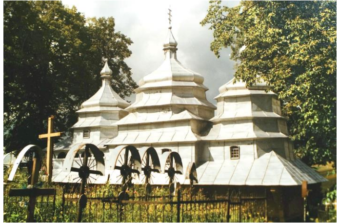
Fig. 12. Kalne - a wooden church now covered with a steel sheet. Source: photo. author, 2000 Ryc. 12. Kalne – drewniana cerkiew pokryta współcześnie blachą stalową. Źródło: fot. autora, 2000
