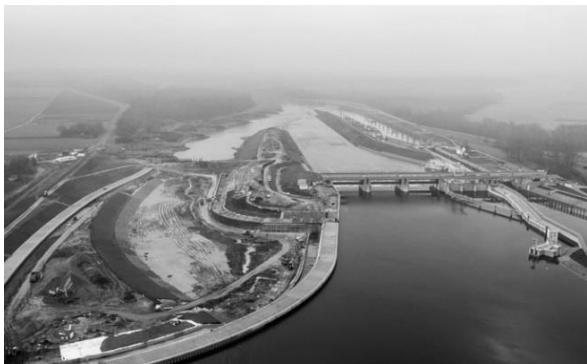
Rys. 4. Stopień wodny Malczyce – stopień rozbudowy 2019 r. [13]
