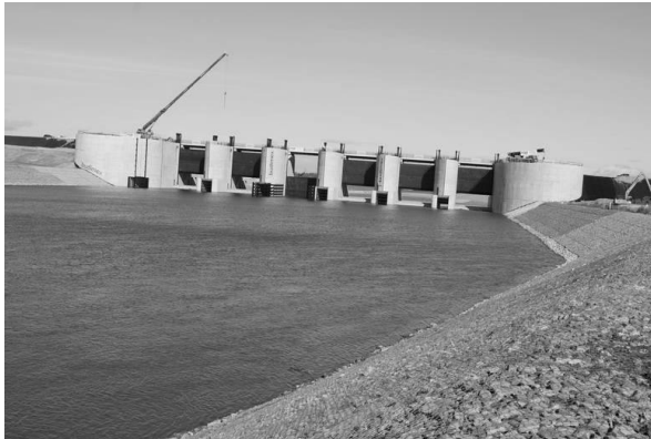
Rys. 3. Zbiornik Racibórz – aktualny poziom rozbudowy, 10.2019r. [12]
