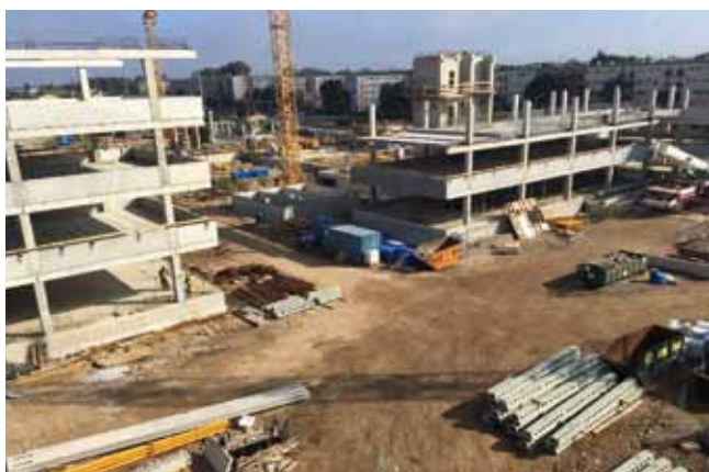
Rys. 3. Konstrukcja obiektu w trakcie realizacji
