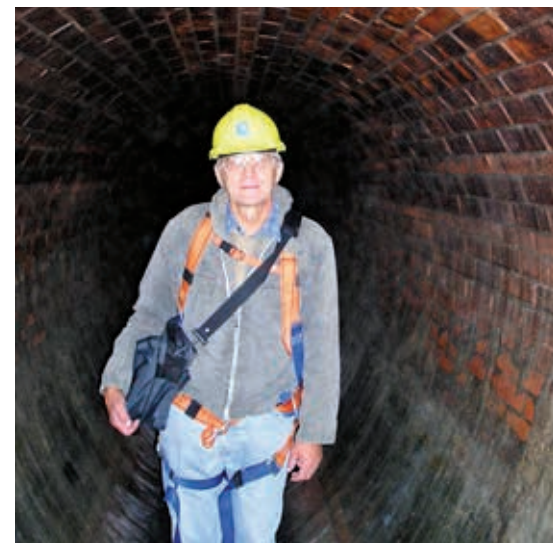
Ryc. 5. Profesor w warszawskim kolektorze kanalizacyjnym w trakcie wykonywania jego ekspertyzy
