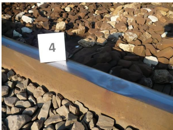
Rys.5. Wada w postaci buksownicy na linii kolejowej Oświęcim – Czechowice Dziedzice . Źródło: Zdjęcia własne
