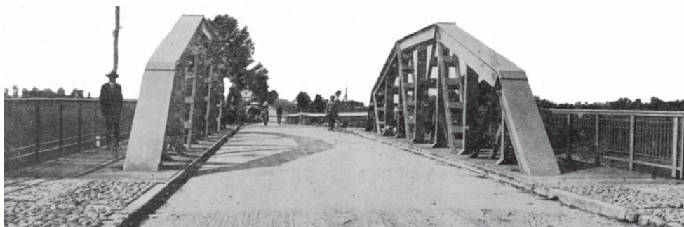
Fot. 1. Most w Maurzycach po ukończeniu prac budowlanych [2]
