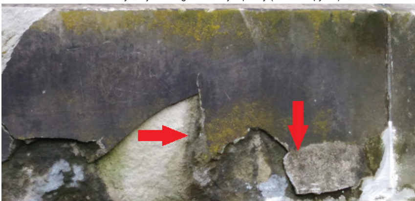
Fot. 3. Rozwarstwienia okładzin kamiennych wskutek trwałego zamakania oraz oddziaływania cykli zamrażania – rozmrażania. Czerwonymi strzałkami pokazano rozwarstwienia okładzin kamiennych (fot. O. Kopyłow)
