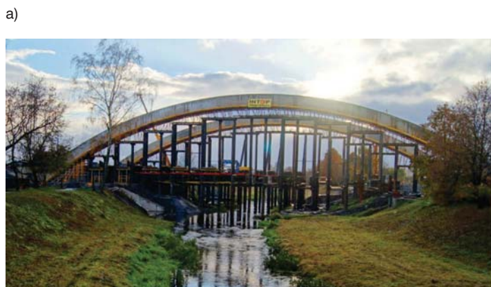
Fot. 3. Rusztowania i deskowania łuków: a) widok z boku, b) podparcie przy wezłowaniu
