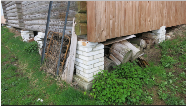
Фото 11. Застосування новітнього способу вирівнювання поверхні під будівництво на поляні, с. Верхня Рожанка (фото власне, 2017)
