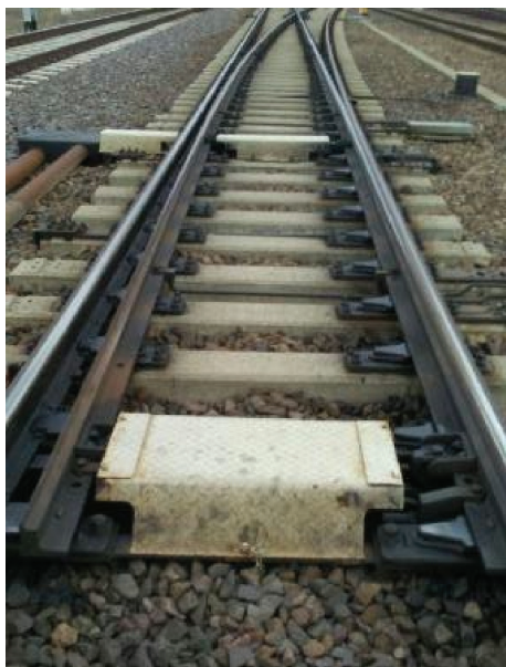
Rys. 1. Rozjazd zwyczajny o skosie 1:12 i promieniu łuku 500 m [fot. autora]
