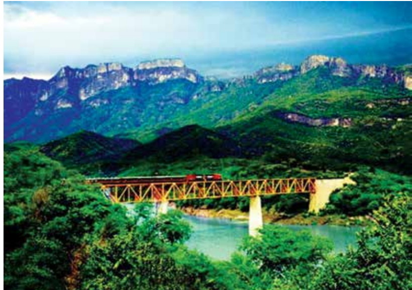
Fot. 4. Przejazd pociągu przez Miedziany Kanion [16]
