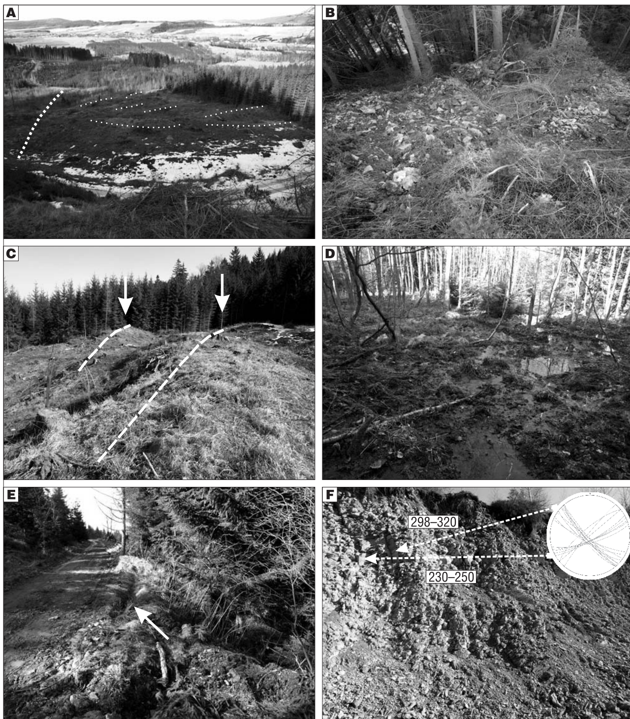
Ryc. 4. A – zachodnia część osuwiska na górze Drogosz; widoczna granica koluwium osuwiska (linia kropkowana z lewej) oraz wtórne skarpy w jego obrębie (linie drobnokropkowane z prawej); B – ześlizg zwietrzeliny (mułowce krzemionkowe) poniżej górnej krawędzi skarpy głównej; C – wtórne skarpy (linie przerywane) w obrębie osuwiska; D – młaki i bagniska na stoku u podnóża jezora osuwiskowego; E – spękania i ześlizgi (strzałka) na powierzchni drogi gruntowej w obrębie osuwiska; F – silnie spękanе mułowce glaukonitowe i mułowce krzemionkowe, w których utworzyła się skarpa osuwiska na górze Drogosz – odsłonięcie. Orientacja spękań na diagramie (strzałki) Fig. 4. A – View of the western part of the Drogosz hill landslide. Note the boundary of landslide colluvium (to the left) and subordinate scarps within the colluvium; B – Debris slide (siliceous mudstones) below the upper edge of the main scarp; C – Minor scarps (dashed line) within the landslide; D – Bog springs and swamps on the slope at the base of the landslide tongue; E – Fractures and slides (arrow) on the road pavement transcussing the landslide; F – Outcrop of strongly fractured glauconitic and siliceous mudstones forming the main scarp of the landslide. Diagram shows an orientation of fractures (arrows)
