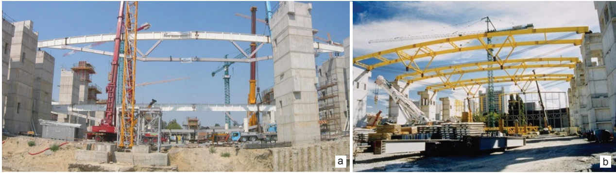
Il. 7. Konstrukcje hybrydowe na terenach targowych w Bolonii: a) pawilon 16-18, b) pawilon 19-20
