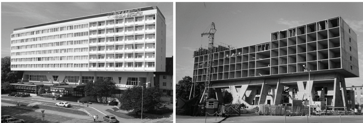
Il. 8. Po lewej – widok elewacji hotelu z lat 90. Po prawej – aksonometryczny widok jego konstrukcji. Widoczne są komórki pokoi zawieszane do dwóch ścian podłużnych (por. il. 9 i 11) wspartych na podłużnej belce skrzynkowej wspartej z kolei na podporach o geometrii typu „A” oraz „X” [4]
