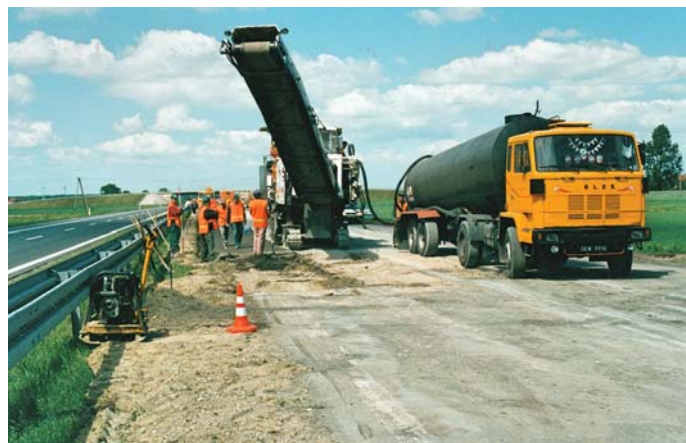
Fot. 3. Zestaw do głębokiego recyklingu. Po lewej stronie recyklarka w trakcie kończenia recyklingu pierwszego pasa nawierzchni odcinka próbnego, a po prawej stronie autocysterna z wolnorozpadową emulcją asfaltową (fot. K. Jabłoński)
