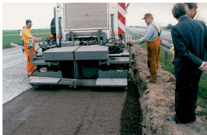
Fot. 5. Sprawdzanie możliwości wypełnienia koryta poszerzenia nawierzchni od strony pasa dzielącego mieszanką mce wytworzoną na miejscu przy pomocy recyklarki – widok z tyłu recyklarki; w korycie poszerzenia zbyt mało mieszanki mce (fot. K. Jabłoński)
