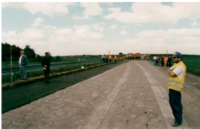
Fot. 6. Pierwszy odcinek próbny – z lewej strony pas recyklowanej nawierzchni (fot. K. Jabłoński)
