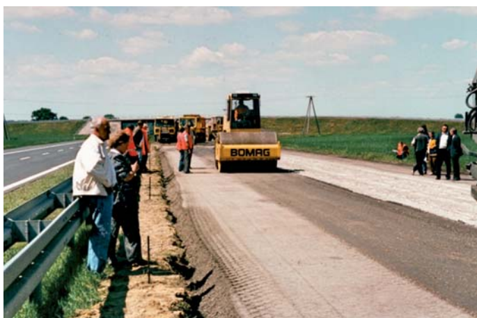
Fot. 7. Zagęszczanie walcem kombinowanym drugiego pasa recyklowanej nawierzchni; z lewej strony zagęszczony już pas recyklowanej nawierzchni i widoczne koryto poszerzenia nie w pełni wypełnione mieszanką mce (fot. K. Jabłoński)
