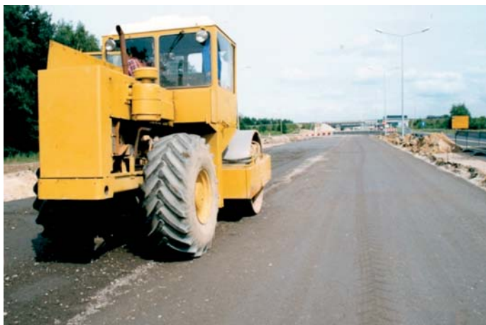
Fot. 11. Dogęszczanie walcami kombinowanymi mieszanki mce wbudowywanej połową szerokości jezdni, na trzecim odcinku próbnym (fot. K. Jabłoński)
