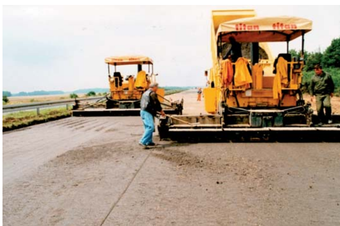
Fot. 12. Wbudowywanie mieszanki mce dwoma układarkami Titan całą szerokością jezdni
