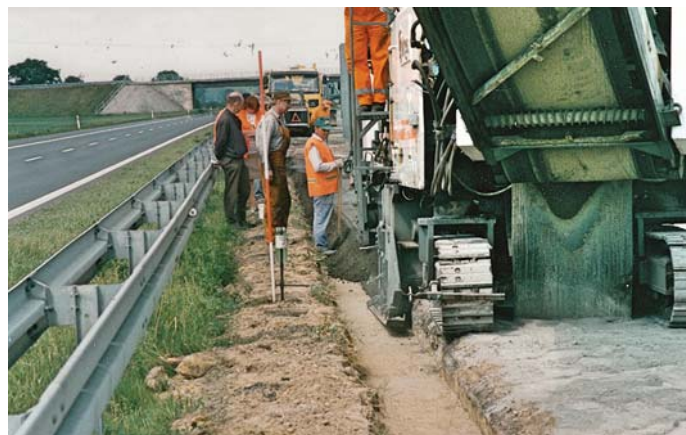
Fot. 4. Sprawdzanie możliwości wypełnienia koryta poszerzenia nawierzchni od strony pasa dzielącego mieszanką mce wytworzoną na miejscu przy pomocy recyklarki – widok z przodu recyklarki (fot. K. Jabłoński)
