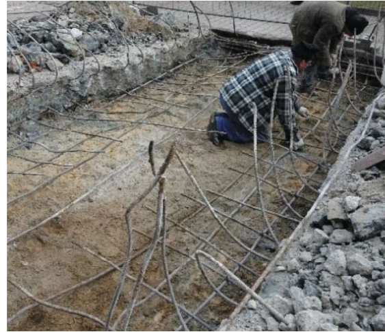
Rys. 8. Naprawa tarczy usztywniającej według koncepcji prof. J. Ledwonía
