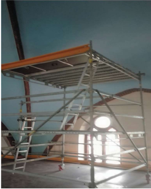
Rys. 7. Rusztowanie przesuwne do obserwacji naprawy sklepienia
