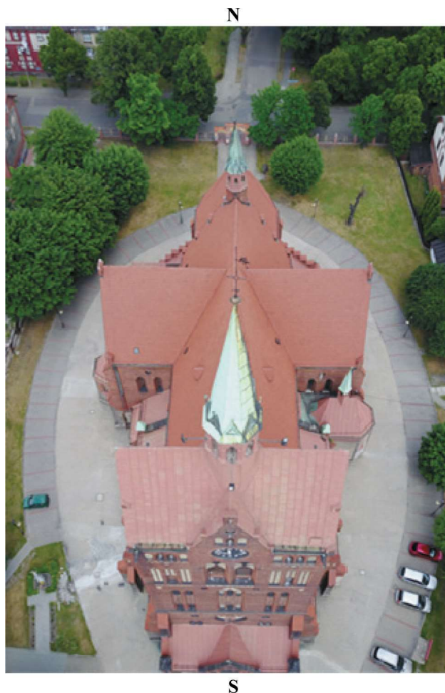
Rys. 4. Widok kościoła z drona, wokół żelbetowa tarcza usztywniająca według koncepcji prof. J. Ledwoń (Mika i in. 2018)
