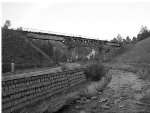
Fot. 2. Wiadukt kolejowy w Jedlinie Zdroju. Photo. 2. The viaduct in Jedlina Zdrój.
