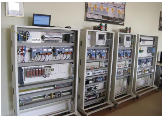
Rys. 10. Most między wewnętrzną siecią Ethernet i systemem gromadzenia danych (sieć Wi-Fi)
