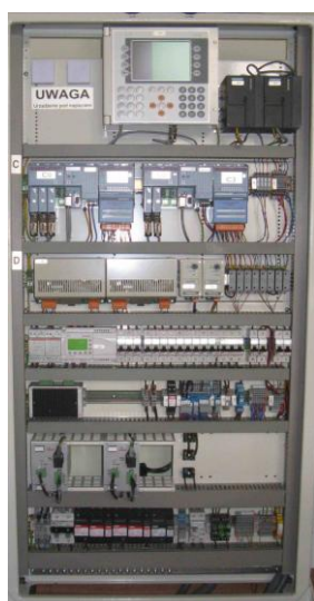
Rys. 3. Rozmieszczenie elementów i widok urządzeń LPS [4]
