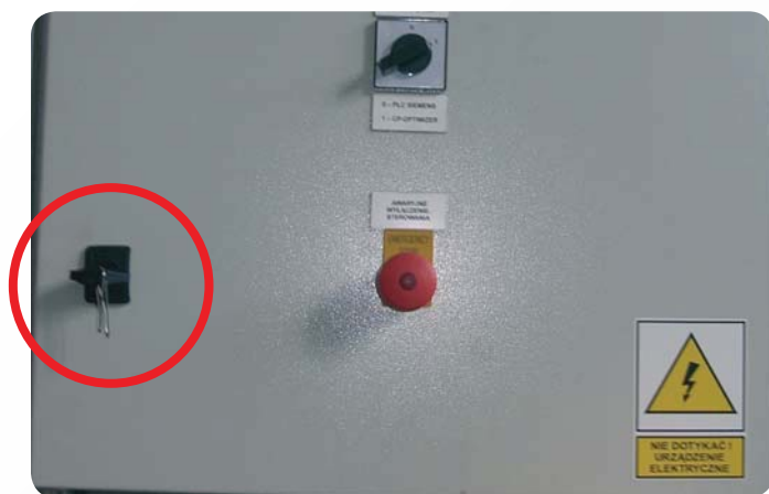
Fot. 1. Klucz pozostawiony w zamku Photo 1. A key left in a lock
