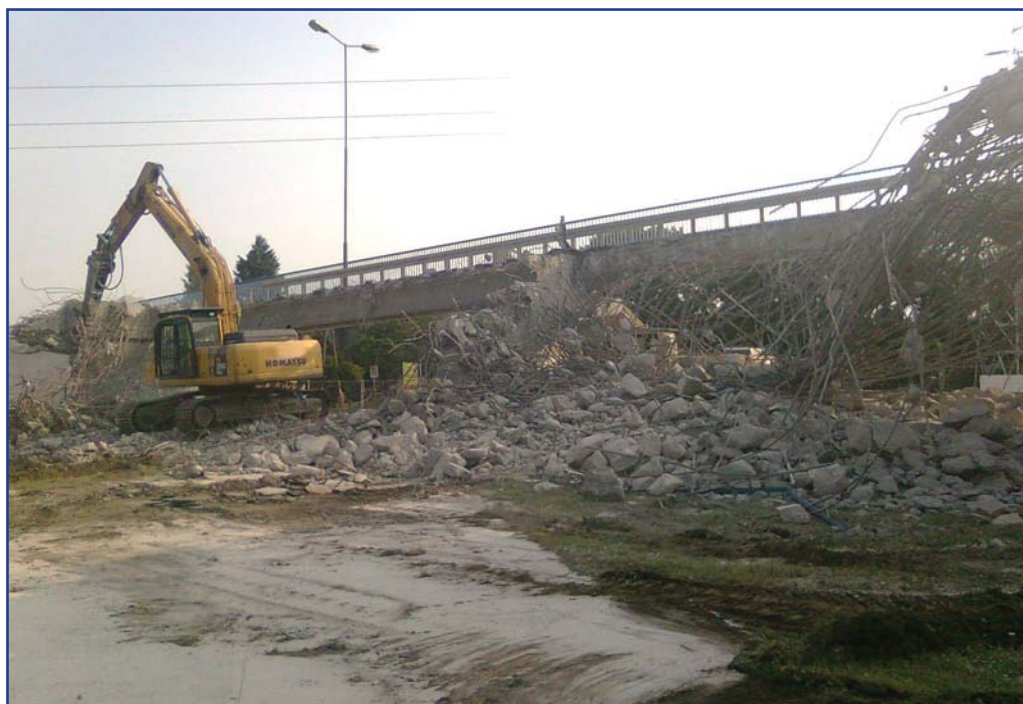
Fot. 1. Rozbiórka Wiaduktu Kosynierów Górczyńskich w Poznaniu – 2012 r. (źródło autora)
