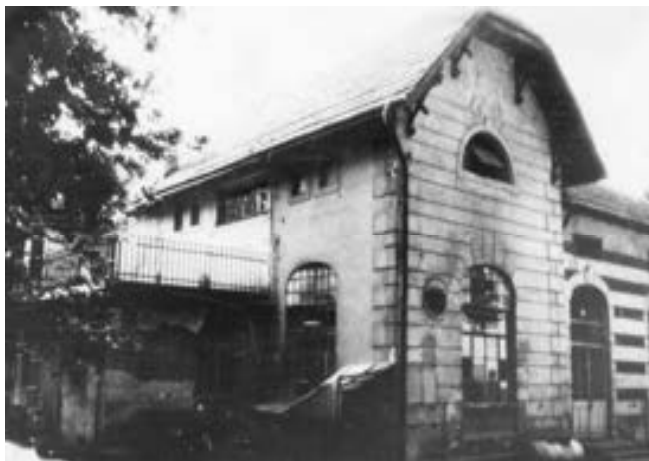
Rys. 3. Budynek Elektrowni Zamkowej z 1906 r. Obecnie po remoncie użytkowany jako kuchnia, pralnia i mieszkania Szpitala Miejskiego
