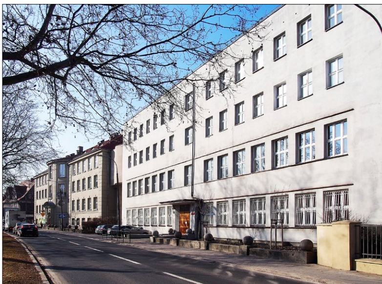
Ryc. 7. Gimnazjum i internat Sióstr Urszulanek w Poznaniu, elewacja frontowa, 2021; fot. autorka.
