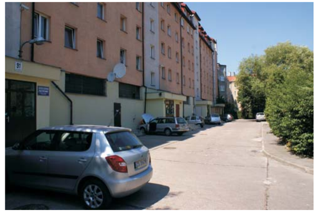
Ryc. 6. Widok od strony wschodniej budynku mieszkalnego przy al. Bohaterów Warszawy 91 w Szczecinie. Linia uskoku pionowych ruchów podłoża gruntowego przebiega w rejonie trzeciej klatki schodowej (Strefa Z1). Fot. L. J. Kaszubowski (lato, 2014) Fig. 6. View from the eastern side of the building at Bohaterów Warszawy 91 in Szczecin. Fault line of vertical movements of the soil substrate passes near the third stairwell (Zone of Z1). Photo by L. J. Kaszubowski (summer, 2014)
