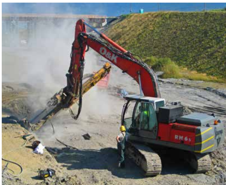
Wykonanie kotwienia palisady
