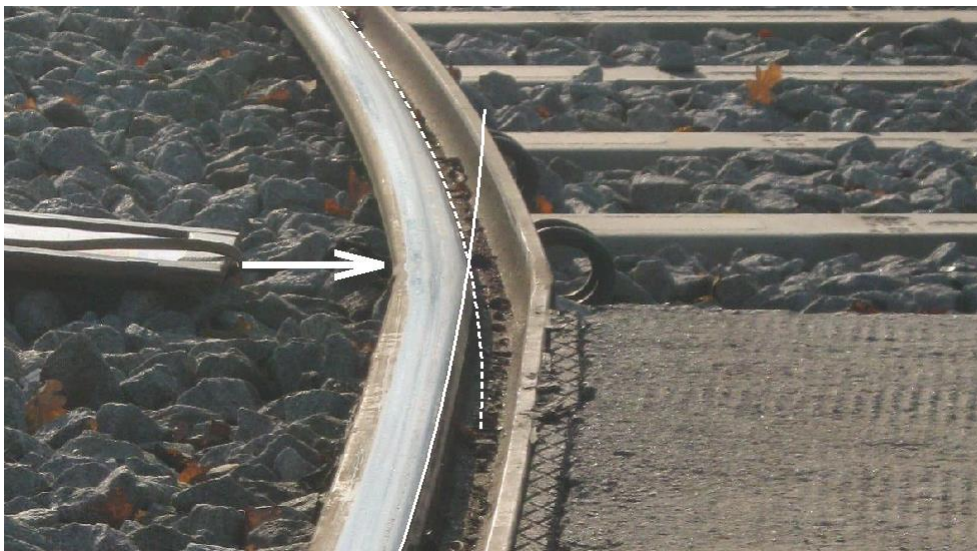
Rys. 3. Tramwajowy tor w łuku o stałym promieniu R = 25 m, za końcem przejazdu drogowego – na pętli Oporów (zdjęcie wykonane zgodnie z kierunkiem ruchu)
