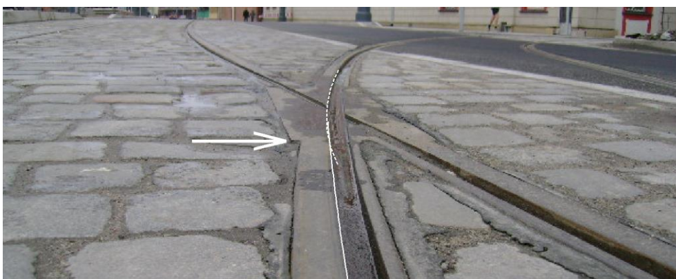
Rys. 2. Tramwajowa relacja skrzyżna z ul. Szewskiej w ul. Grodzką (zdjęcie wykonane przeciwnie do kierunku ruchu)
