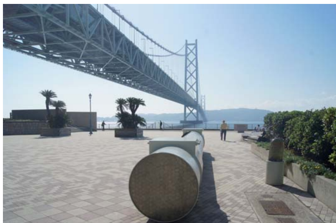
Fot. 23. Przekrój lin głównego ciężna
