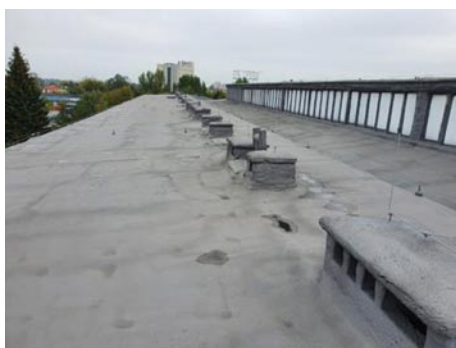
Rys. 2. Widok pokrycia i konstrukcji nośnej dachu
