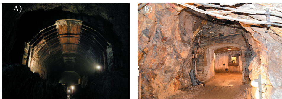
Ryc. 2. A) Niedokończona hala z pozostawionymi szalunkami – obiekt „Osówka”; B) wejście do wartowni w sztolni nr 1 – obiekt „Rzeczka”
