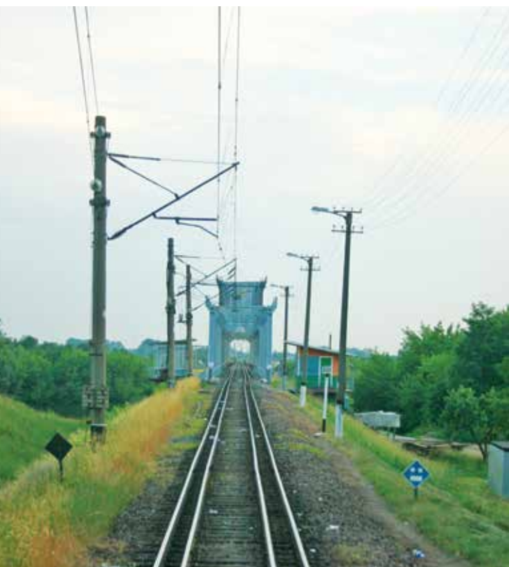
Odcinek Terespol-Park Bug po stronie białoruskiej (1435 mm + 3 kV DC, 1520 mm niezelektryfikowany). Fot. P. Czech (15.06.2007 r.)
