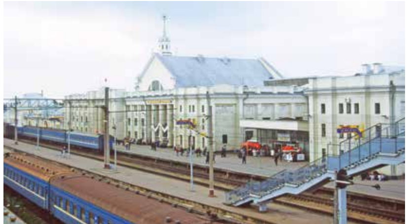
Dworzec w Brześciu, część moskiewska (1520 mm, 25 kV 50 Hz) (5.09.2001 r.)
