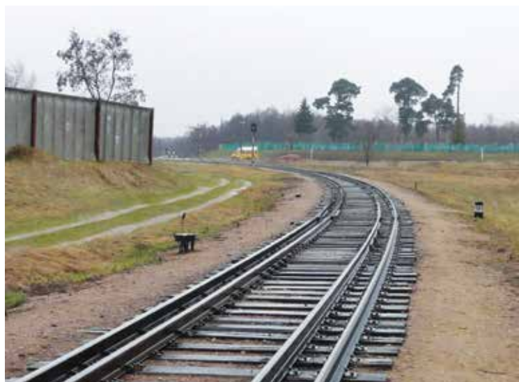
Splot toru 1435 mm + 1520 mm na stacji Brześć Północny (1.04.2010 r.). Fot. M. Kulgejko
