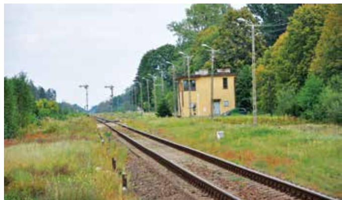
LK 31 i stacja w Narewce, zachodnia głowica wyjazdowa (3.09.2016 r.)
