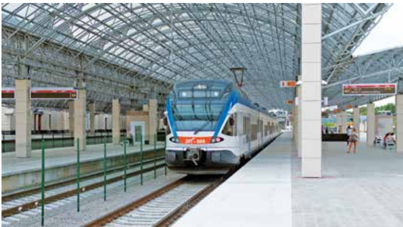
Flirt EP R -009 kolei BC na stacji w Brześciu (1520 mm + 25 kV 50 Hz), część warszawska: tory nr 1 i 2 (od lewej strony) o rozstawie 1435 mm, nr 3 i 4 - o rozstawie 1520 mm (18.07.2014 r.). Fot. D. Szczukin
