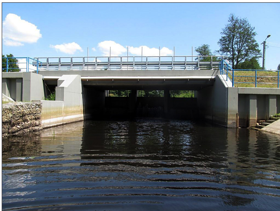
Rys. 2. Widok nowego jazu w Skórcie od strony dolnej wody Fig. 2. Downstream view of new the Skórka weir
