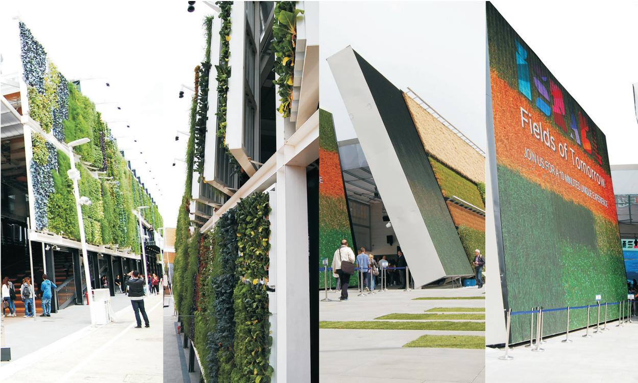
Ryc. 3. Fragmenty elewacji pawilonu Stanów Zjednoczonych oraz pawilonu Izraela; źródło: fot. autor Fig. 3. Fragments of facade the United States pavilion and Israel pavilion; source: photo by the author
