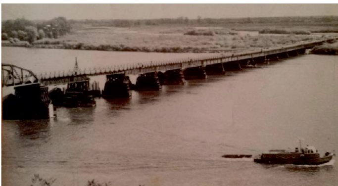
Fot. 6. Most przez Wisłę w Wyszogrodzie po odbudowie na pocztówce wysłanej w listopadzie 1963 r. (zbiór autora)
