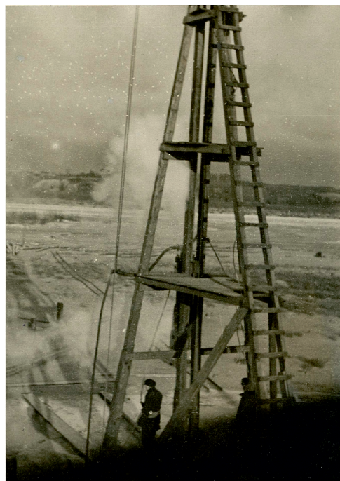
Fot. 3. Kafar parowy podczas wbijania pali wyszogrodzkiego mostu (zbiór Jana W. Rudominy)
