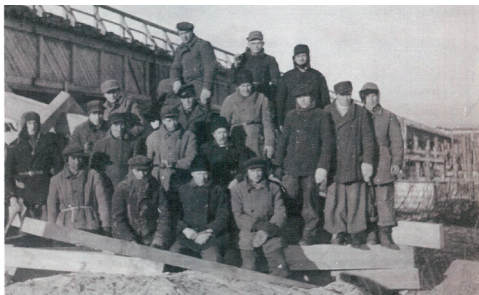
Fot. 4. Pracownicy firmy Przedsiębiorstwo Robót Pałowych Bolesław Liśkiewicz w Wyszogrodzie przy odbudowywanej izbicy mostu (zbiór Jana W. Rudominy)
