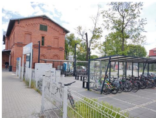
Rys. 3. Odremontowany dworzec w Pobiedziskach pełni również funkcję węzła przesiadkowego oraz od jesieni 2022 r. biblioteki gminnej
