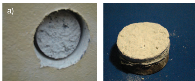
Mechanizm zniszczenia: 100% w tynku Napężenie niszczące: 0,056 MPa
