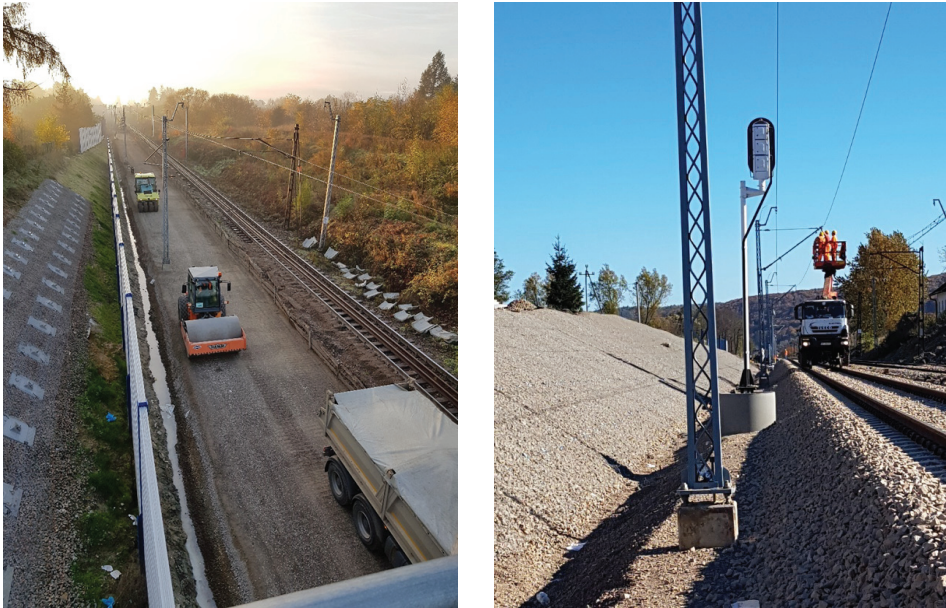
Fot. 2. Prace na odcinku Kraków Mydlniki – Krzeszowice (linia nr 133)
