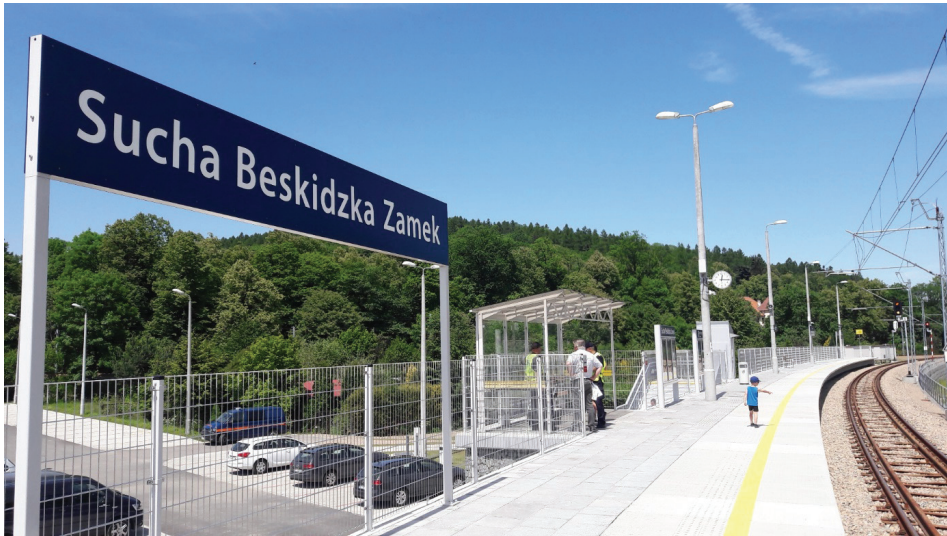
Fot. 6. Przystanek osobowy Sucha Beskidzka Zamek na nowo wybudowanej łącznicy
