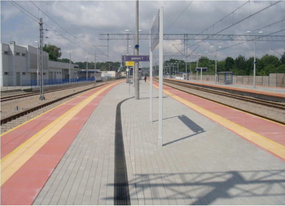
Fot. 3. Zmodernizowana stacja Brzesko Okocim (linia nr 91)
