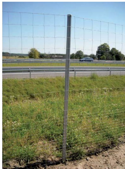
Fot. 2. Słupek pośredni z blachy zwijanej
