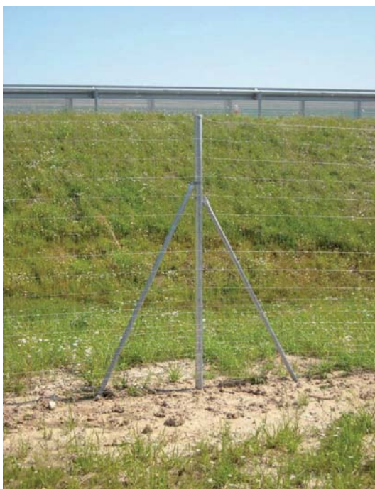
Fot. 3. Słupki naciągowy i dwa podporowe z rur ze szwem
