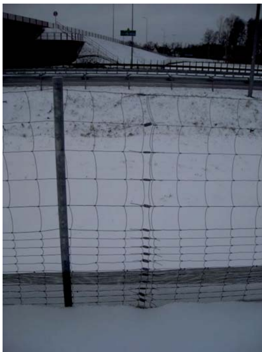
Fot. 6. Połączenie siatki za pomocą złączek
