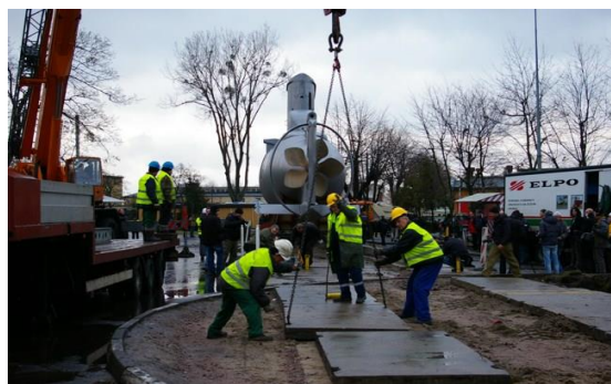
Fot. 11. Okręt podwodny typu 207 podczas operacji układania specjalnego podłoża do transportu. Źródło: Archiwum AMW
