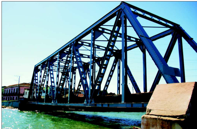
Fot. 8. Most kolejowy Dubrocq w Matanzas z 1904 r. po remoncie
