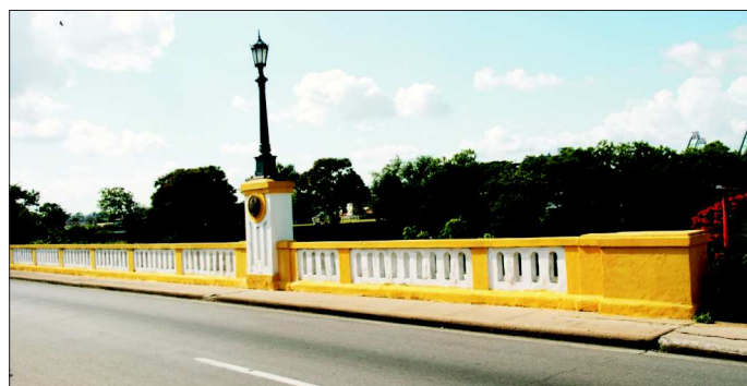
Fot. 15. Odnowione balustrady mostu nad rzeką Guamá w Pinar del Rio
