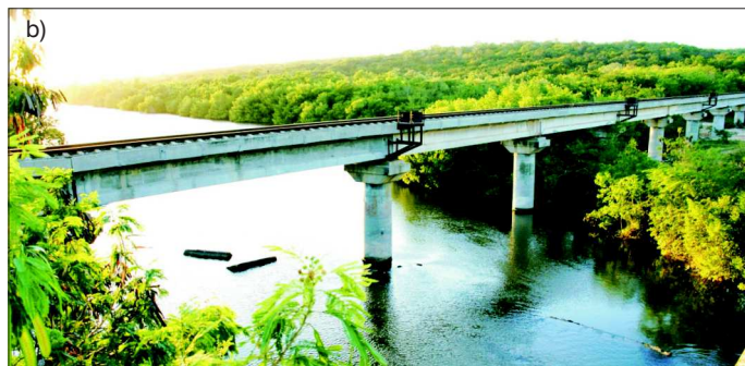
Fot. 27. Przykłady mostów z belek prefabrykowanych: a) drogowy na A-1, b) kolejowy
