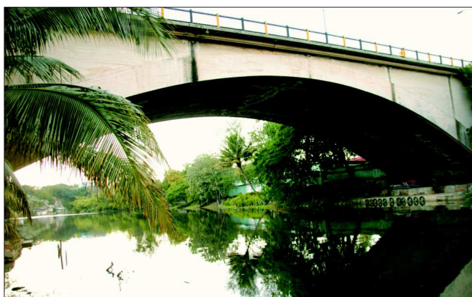
Fot. 12. Most Almendares w Hawanie z 1911 r. – pierwszy most żelbetowy na Kubie
