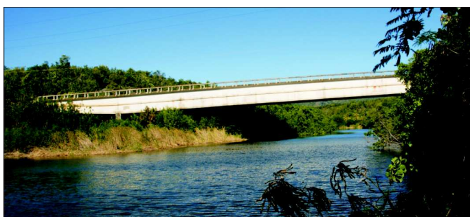
Fot. 20. Most Cañas – pierwszy z betonu sprężonego
