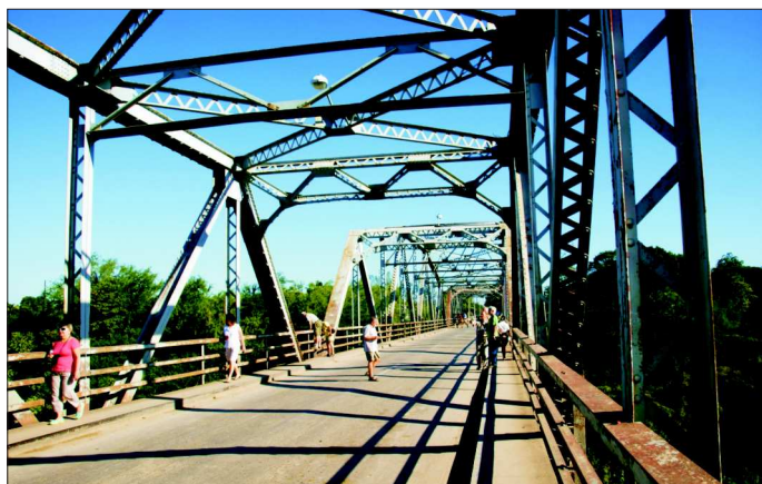
Fot. 17. Most w Cauto Cristo, kratowy trójprzęsłowy
