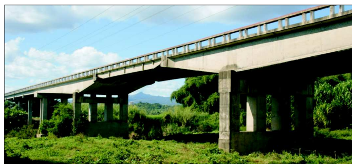
Fot. 22. Most Agabama z przęsłem gerberowskim i sprężonymi ramownicami
