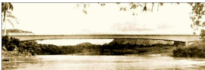
Fot. 23. Most Cuyaguatėje – największy z kablobetonowych w latach 50. [5]
