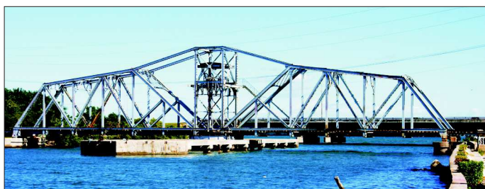
Fot. 9. Kolejowy most obrotowy Giratorio w Matanzas z 1904 r.
