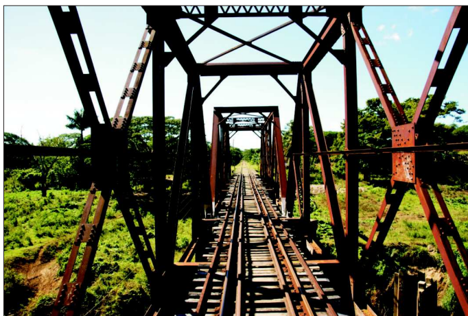
Fot. 11. Most kolejowy 5-przęsłowy na linii do Doliny Cukrowni (Valle de los Ingenios)
