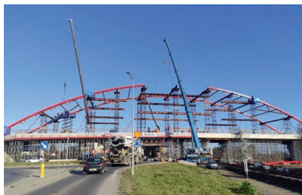
Rys. 16. Mielec – nowy wiadukt drogowy (3.12.2022 r.) [fot. A. Stec / PLK]
