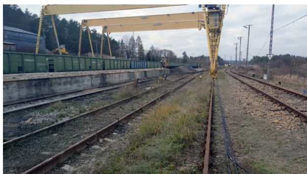
Rys. 23. Prace przeładunkowe na stacji Werchrata (LK 101) (31.07.2021 r.) [fot. J. Klimek / PLK]
