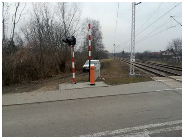
Rys. 19. Lokalizacja budowy nowego przystanku Przemyśl Wschodni (1.04.2023 r.) [fot. Ł. Fronc / PLK]
