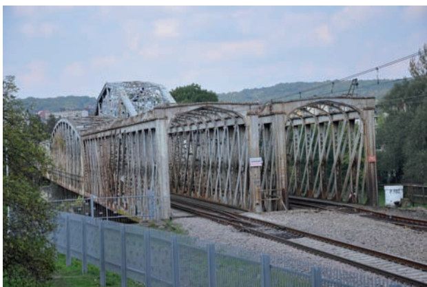
Rys. 6. Most na Sanie w Przemyślu do 2023 r. (16.09.2016 r.) [fot. M. Graff]
