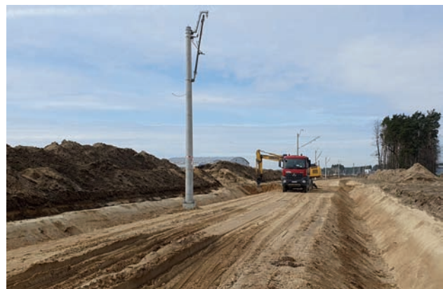
Rys. 15. Budowa linii kolejowej do lotniska Rzeszów Jasionka (1.04.2023 r.) [fot. P. Hamarnik / PLK]
