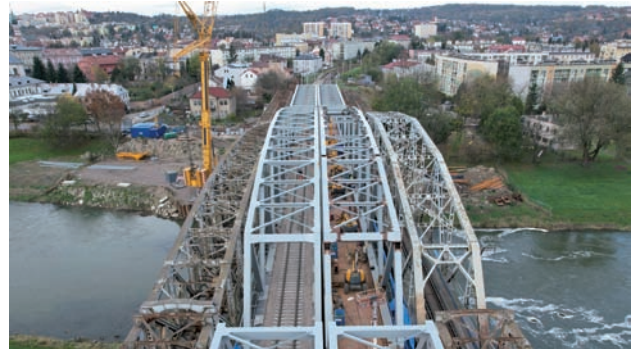
Rys. 7. Nowy most kolejowy na Sanie w Przemyślu [fot. T. Warszawski / PLK]
