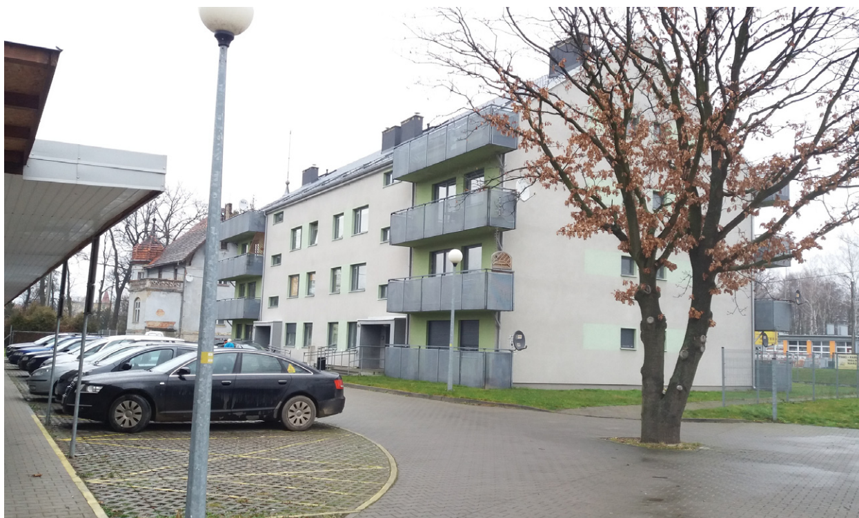
Ryc. 7. Budynki zabudowy mieszkaniowej wielorodzinnej we własności gminy Kąty Wrocławskie, przy ul. Nowowiejskiej 9a-b; fot. autorka
