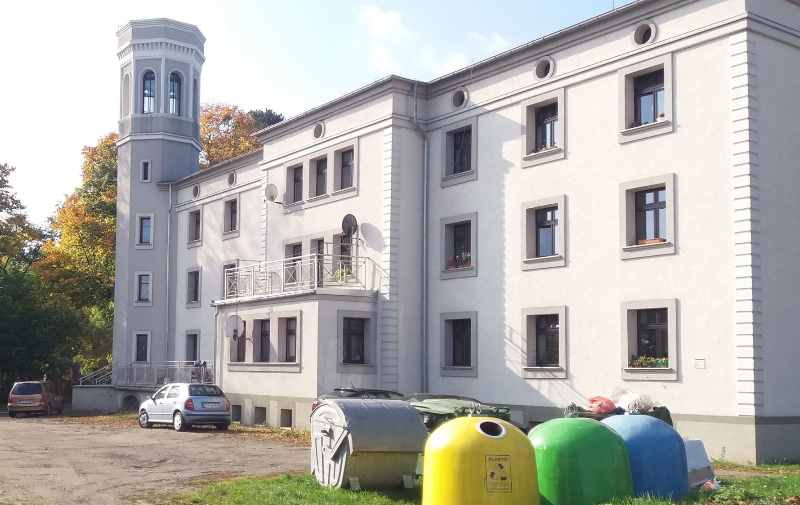
Ryc. 9. Budynek zabudowy mieszkaniowej wielorodzinnej we własności gminy Oborniki Śląskie, przy ul. Podzamcze 7; fot. autorka
