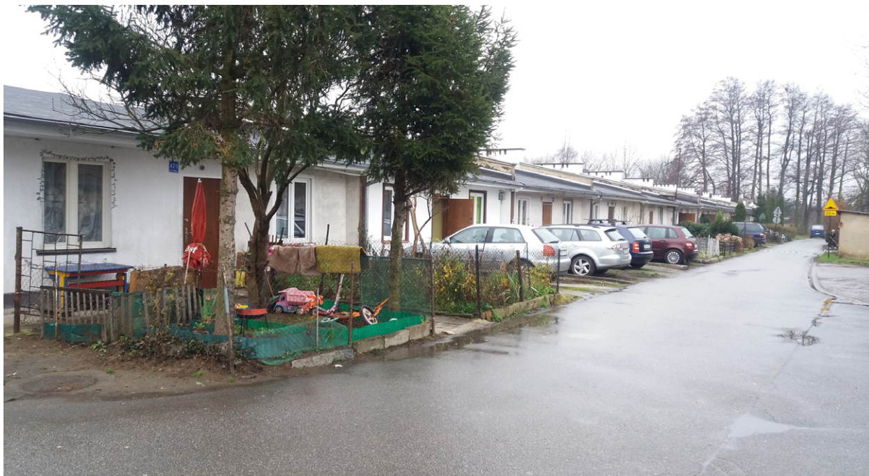
Ryc. 8. Budynki zabudowy mieszkaniowej wielorodzinnej we własności gminy Kąty Wrocławskie, przy ul. 1 Maja 47; fot. autorka
