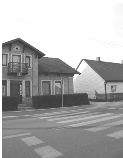
Ryc. 4. Kazimierza Wielka – ul. Marszałka Piłsudskiego, obiekt z oryginalną ceglana elewacją i obok elewacja z sidingu (Fot. J. Czarny-Piotrowska)
