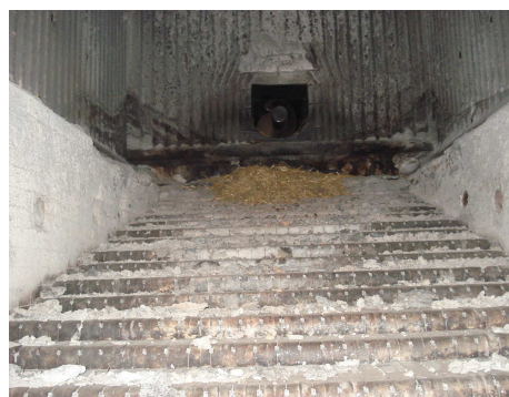
Rys. 2. Zdjęcie ruchomego rusztu
