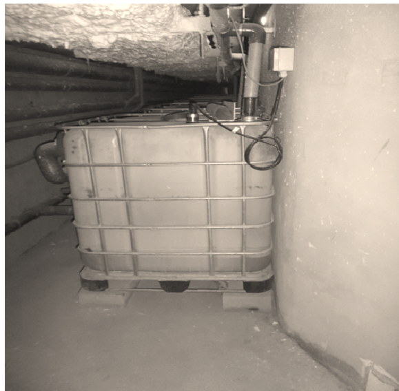
Rys. 3. Pojemniki, w których magazynowana jest odzyskana szara woda z prania Autor: A. Grzelak (11.04.2015)
