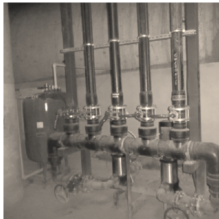
Rys. 6. System rur do ochładzania agregatów
