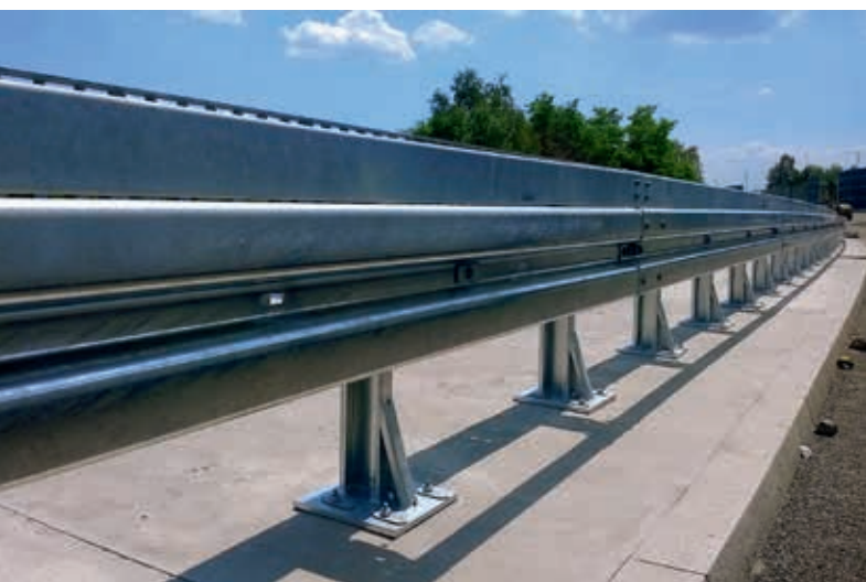
Droga krajowa nr 1, Tychy, bariera mostowa H2 W4 A, fot. Sigmateq Polska
