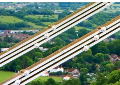
Płytowe łańcuchy mostu Clifton [14]
